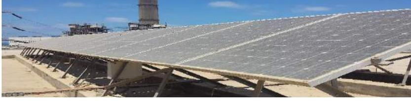
● محطة الطاقة الشمسية اعلى مبنى المخازن بمحطة كهرباء سيدي كرير قدرة ٢٥ك.و وتحتوى على عدد ١٩٥ خليه شمسية قدرة ٢٧٠ ك.و
